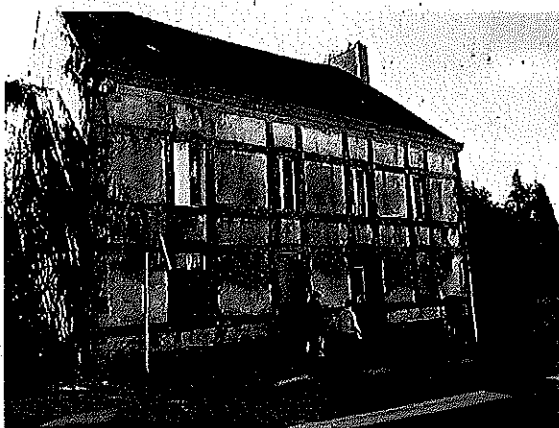
VUE FACADE SUR RUE
