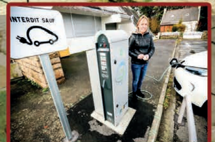
La commune se modernise
