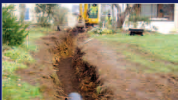
Réfection des réseaux à Kerguyader
