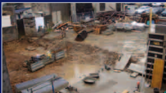
Le réaménagement de l' Espace Toupin est en cours
